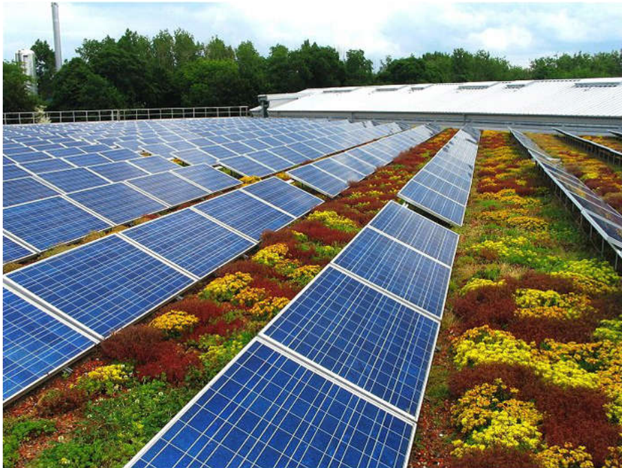
Beispiel: Dachbegrünung mit Photovoltaikanlage, Quelle: Stadt Dresden
