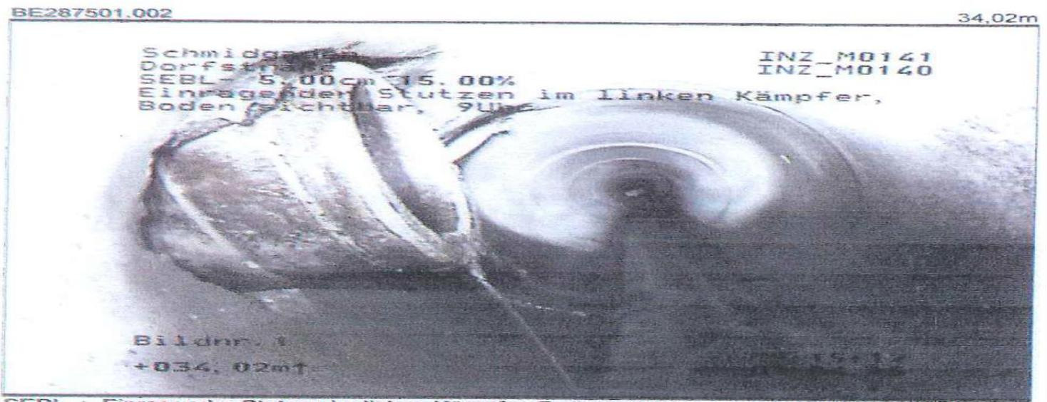
SEBL- : Einragender Stutzen im linken Kämpfer, Boden sichtbar, 9Uhr 5.00 cm, 15.00% Querschnittsflächenreduktion
